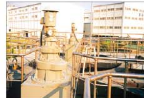
化學工廠刮泥設備
