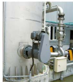
側插桶槽(單卡夾+格蘭軸封)
