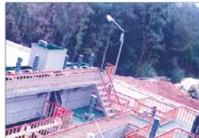
酒廠廢水處理
