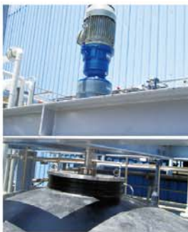
化工儲槽(格蘭軸封)
