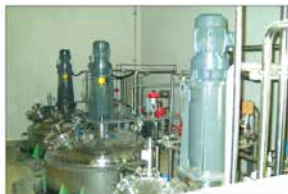
生化科技設備
